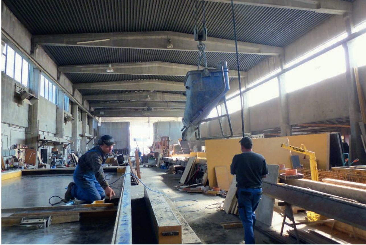
Bild 1 Innenleben eines Beton- werks: Max Koch GmbH in Steißlingen.
